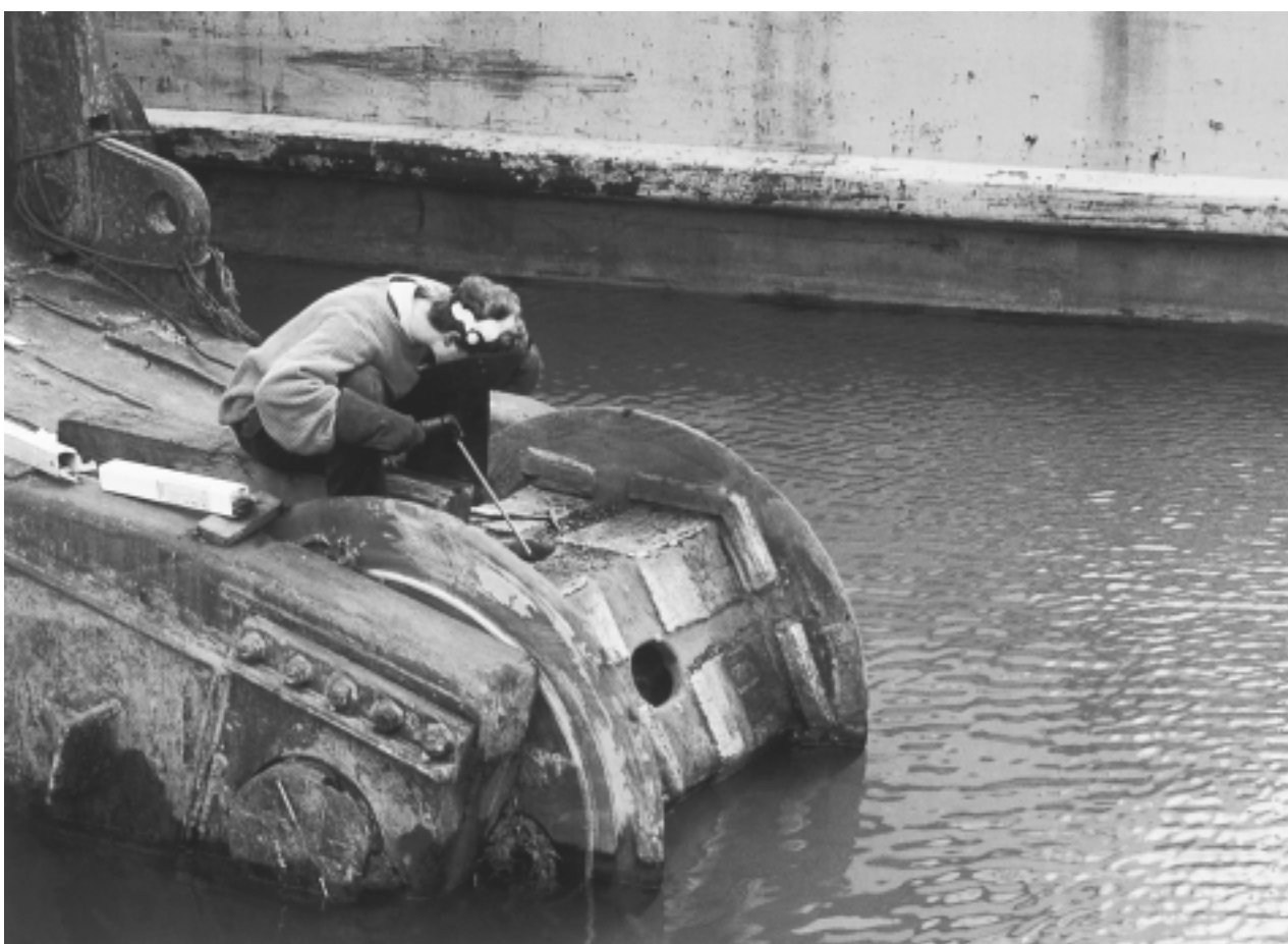
Наваряване на въртящ се барабан. Изграждане с ОК 83.28
