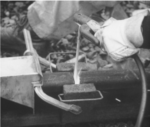
Съединяване на релси чрез заваряване във форми: ОК 74.78
