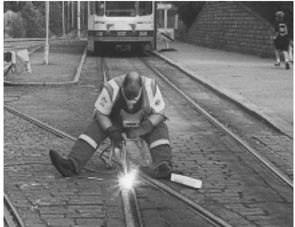
Ремонт на трамвайна релса: ОК 67.52
