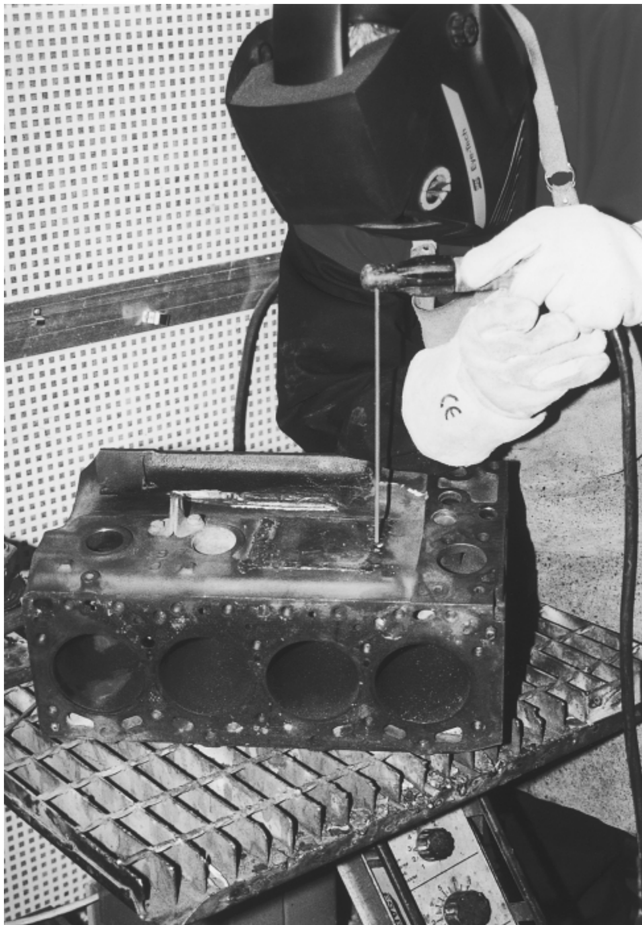
Двигателен блок. Ремонт на чугунена отливка с ОК 92.18 и ОК 92.60
