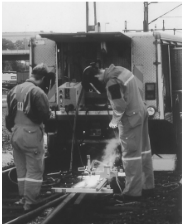
Механизирано заваряване: Railtrack BV/ ОК Tubrodur 15.43
