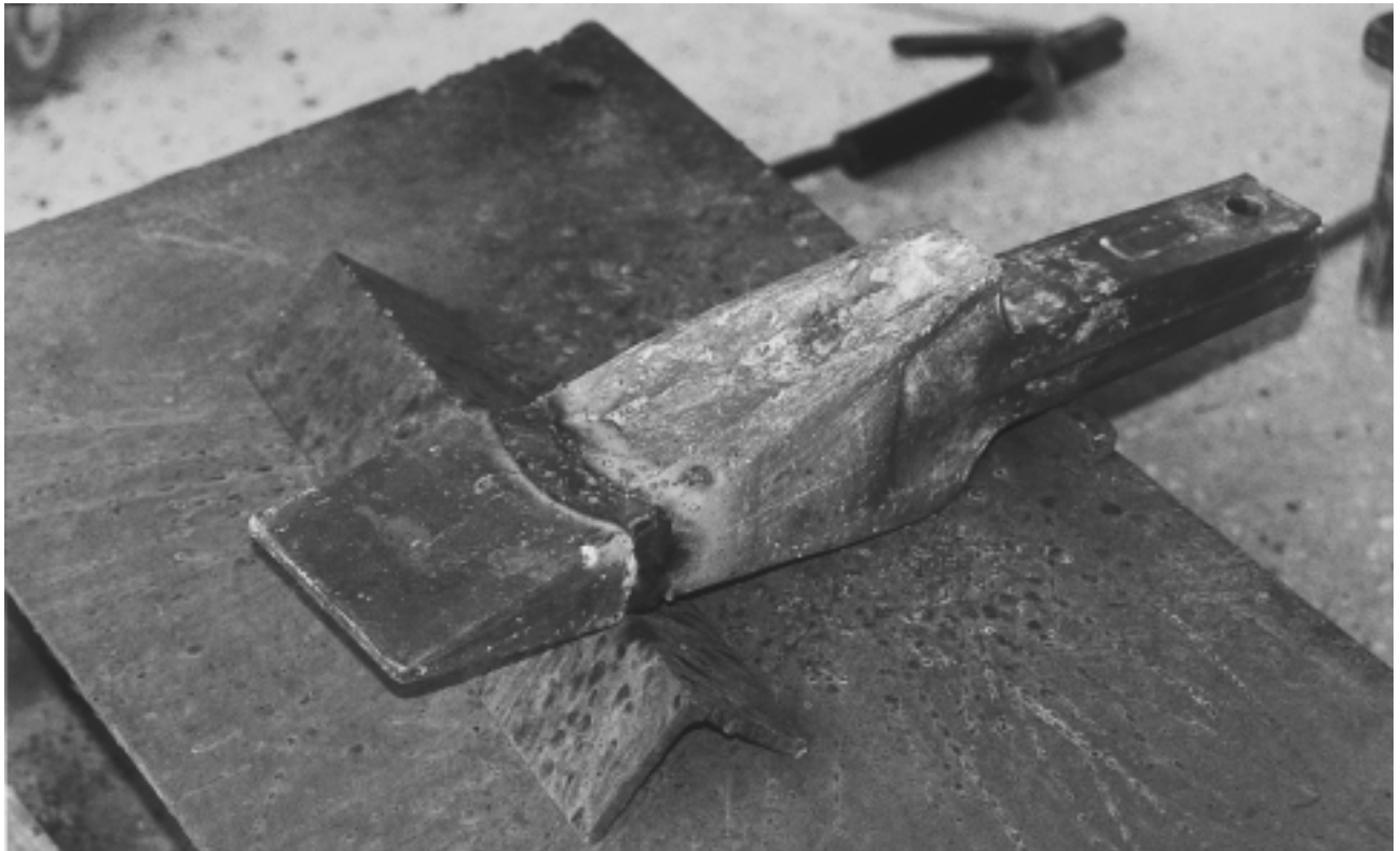
Ремонт на върха на зъб от багерна кофа с ОК 67.45 или ОК Tubrodur 14.71.
