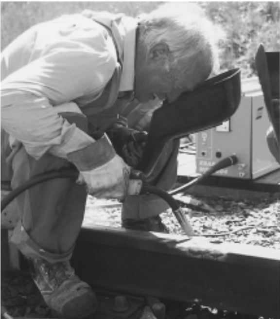
Ремонт на подкопана от колелата релса. ОК Tubrodur 15.43
