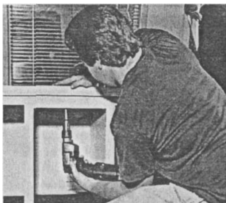
Это гораздо легче сделать, если вы дожидаетесь, пока шкаф будет установлен, прежде чем закреплять крышку.
