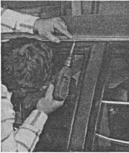
Следующий шаг — снять герметизирующий уплотнитель с дверных проемов.
