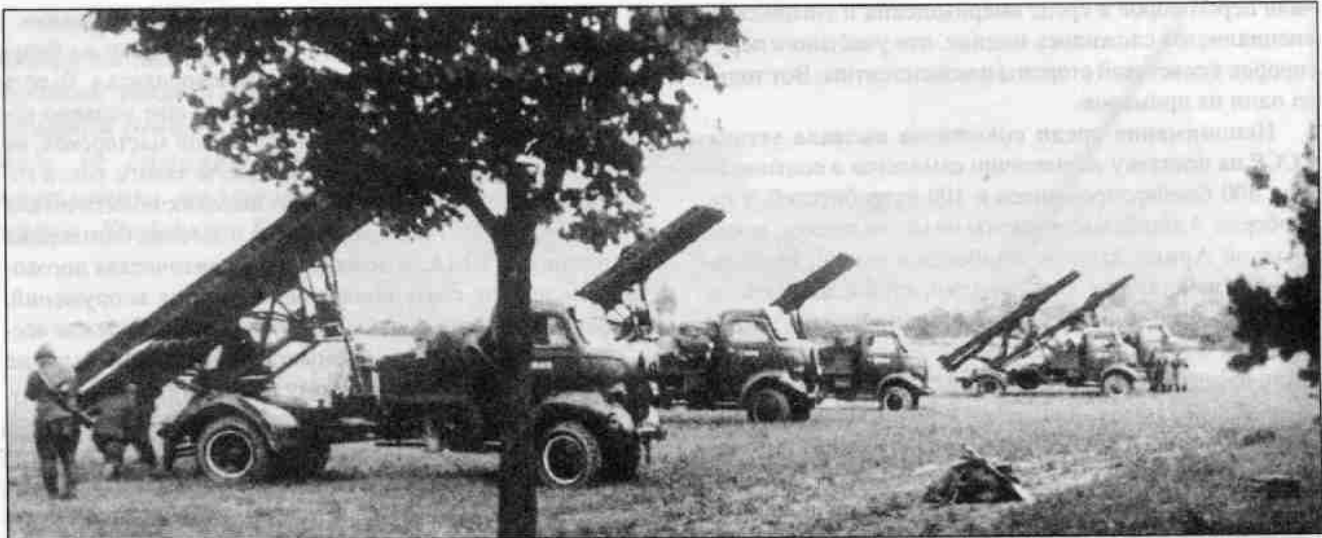
Батарея М-13-16 на шасси Ford-Marmon-Harrington NN-6 SOE-4. Декоративные белые круги на покрышках свидетельствуют, что снимки сделаны, скорее всего, на полигоне.
