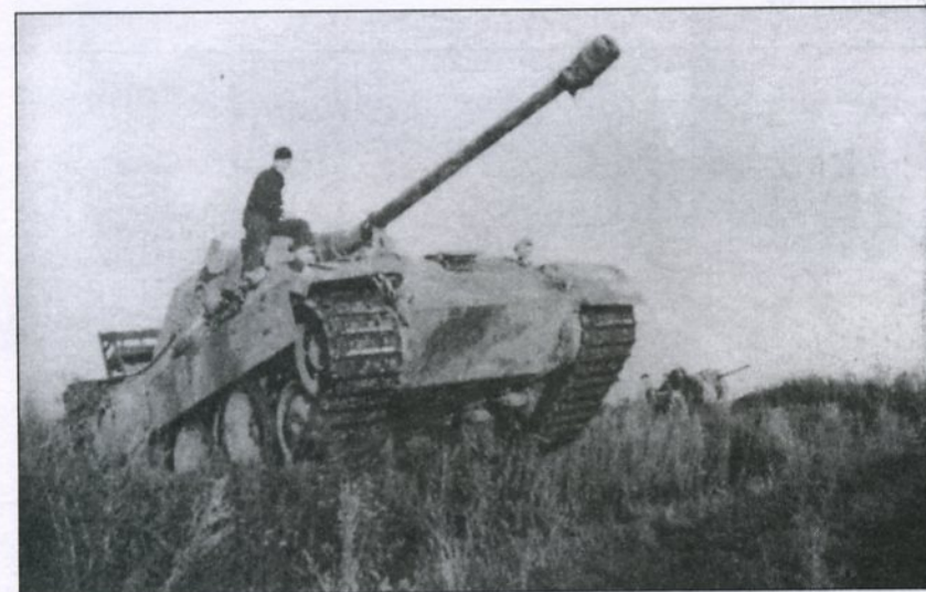
«Пантера» № 632 взбирается по склону. Движение вверх по склону было очень опасным, так как при этом показывалось тонкое днище танка. При этом угол атаки лобовой брони уменьшался до нуля. На крышу двигательного отделения поставлена скамья, что делает машину не только боевым танком, но и средством транспортировки мотопехоты.
