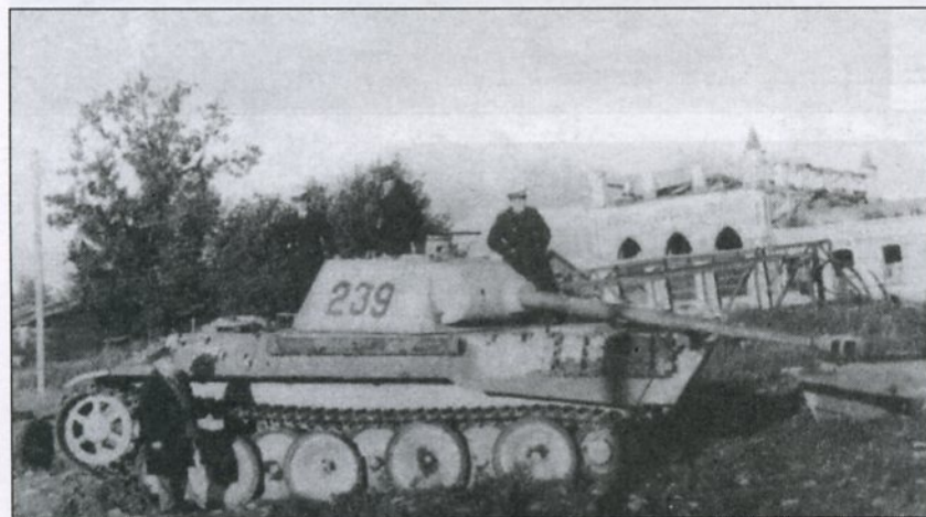
«Пантера» Ausf. D раннего выпуска получила попадание в борт баши, что и послужило причиной выхода танка из строя. Смотровой прибор механика-водителя и люк курсового пулемета открыты. Видны крепления для дымовых гранатометов.
