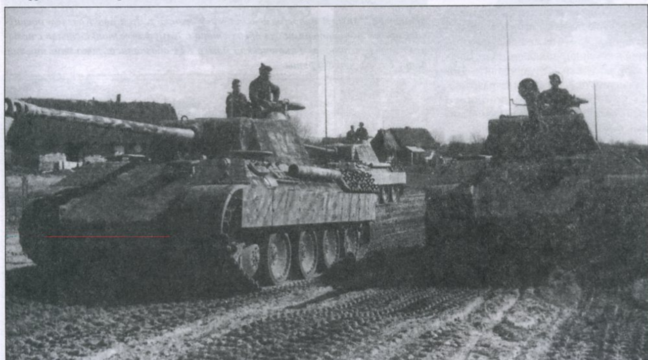
«Пантера» Ausf. A ранней производственной серии, Умань, конец 1944 года. У танка отсутствует правая фара. Командирская башенка литая. Гусеницы оснащены антипробуксовочными зубьями. Справа от ствола пушки видны два отверстия для бинокулярного прицела. Фотография дает представление о том, насколько тяжело приходилось немецким транспортным частям на Восточном фронте. «Пантера» готовится тянуть увязший грузовик.
