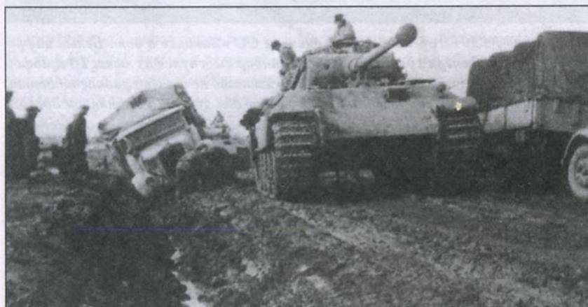
«Пантера» Ausf. A ранней производственной серии, Умань, конец 1944 года. У танка отсутствует правая фара. Командирская башенка литая. Гусеницы оснащены антипробуксовочными зубьями. Справа от ствола пушки видны два отверстия для бинокулярного прицела. Фотография дает представление о том, насколько тяжело приходилось немецким транспортным частям на Восточном фронте. «Пантера» готовится тянуть увязший грузовик.
