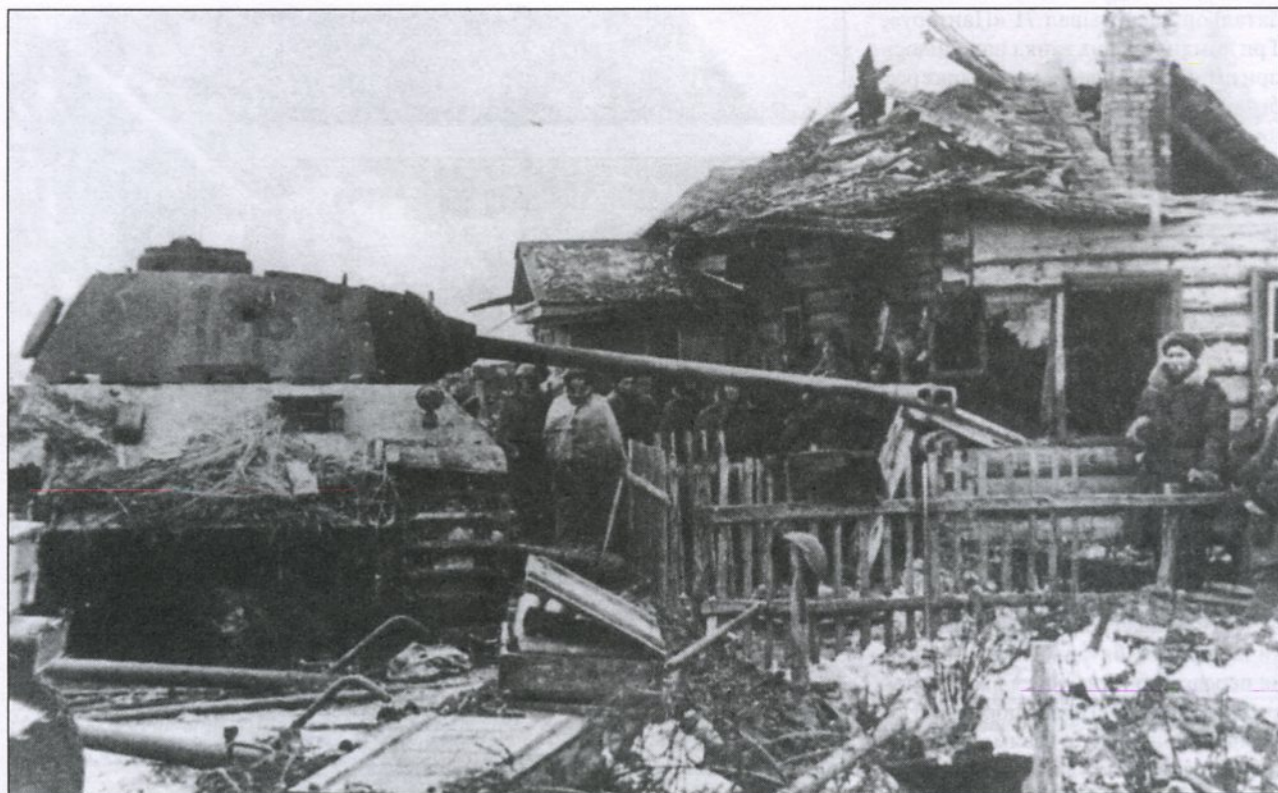
«Пантера» Ausf. D раннего выпуска получила попадание в борт баши, что и послужило причиной выхода танка из строя. Смотровой прибор механика-водителя и люк курсового пулемета открыты. Видны крепления для дымовых гранатометов.
