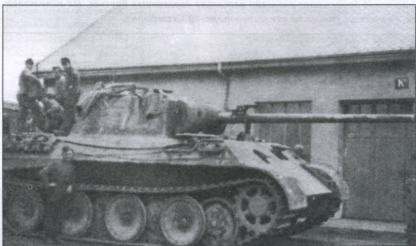
24-й танковый полк сформировали в 1943 году. После года на фронте полк отправили во Францию для пополнения. Фотография сделана вскоре после того, как полк прибыл на полигон Вуссер. «Пантера» на фотографии - Ausf. D поздних выпусков. Командирская башенка имеет кольцо для зенитного пулемета. Дымовые гранатометы сняты. На ствол пушки установлен имитатор орудийного огня.
