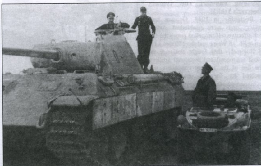
Эта командирская «Пантера» Ausf. D принадлежала 5-й танковой дивизии СС «Викинг». Командир танка обрисовывает ситуацию стоящим на земле офицером. Звездообразная антенна установлена на башне. Вероятно, это танк SdKfz 268, который поддерживал связь между авиационными и танковыми частями.
