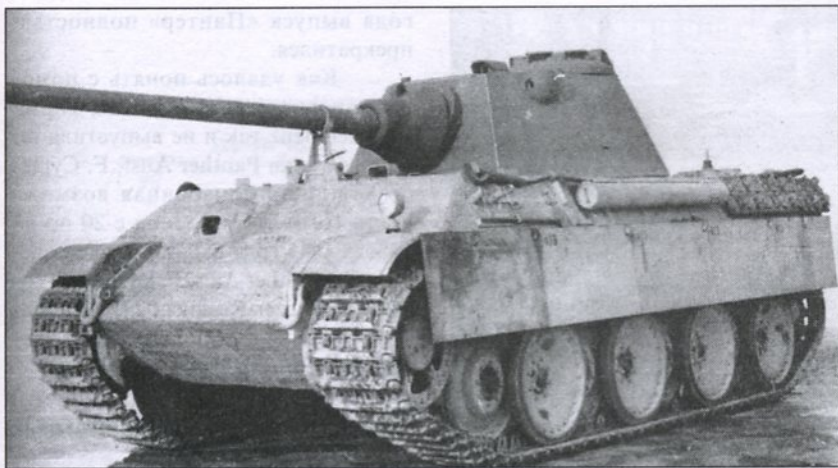
Второй прототип Versuchs-Schmalturn, размещенный на шасси Ausf. G (Fgst.Nr. 120413, собранный фирмой MAN в начале мая 1944 года). В лобовой броне башни нет никаких отверстий, поскольку перископический прицел выведен через крышу.
