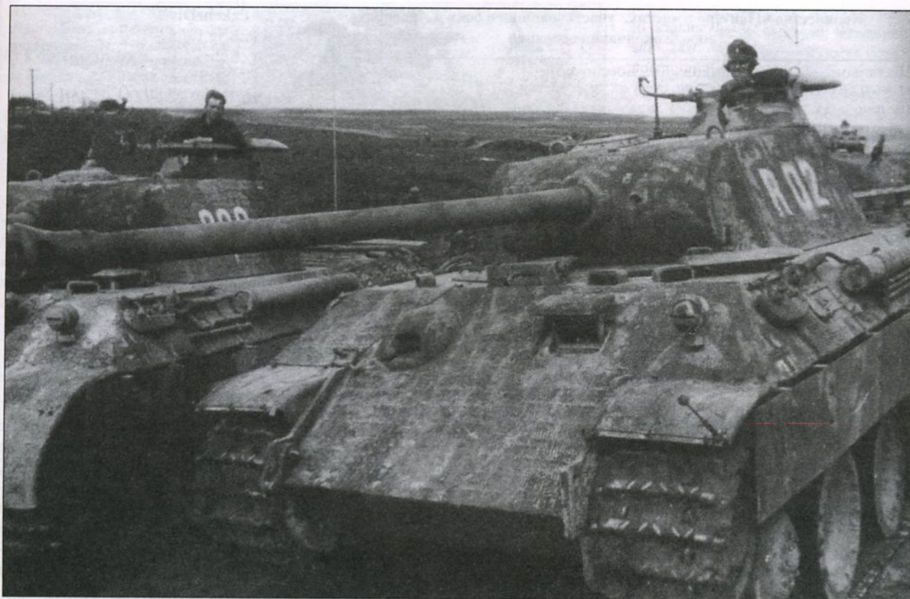
«Пантера» «R 02» штандартенфюрера Мюленкампа, командира 5-го танкового полка 5-й танковой дивизии СС «Викинг». Фотография сделана в районе Ковеля летом 1944 года. Рядом стоит «Пантера» командира 8-й роты. Машина Мюленкампа - командирская «Пантера» Ausf. A, покрытая циммеритом. Обратите внимание на камуфляж танка: зеленые и коричневые полосы нанесены кистью по желтому базовому цвету. Командирская «Пантера» (SdKfz 267) отличалась от обычных боевых танков по двум антеннам: звездообразной на крыше двигательного отделения и штывровой на крыше башни.
