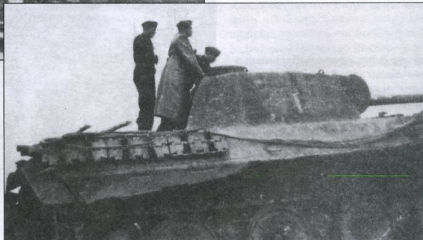
За стрельбами наблюдает командующий танковой группой «Запад», генерал Эбербах (в кожаном пальто). Рядом с генералом стоят два его адъютанта. Циммерит на этот танк наложен крайне небрежно.
