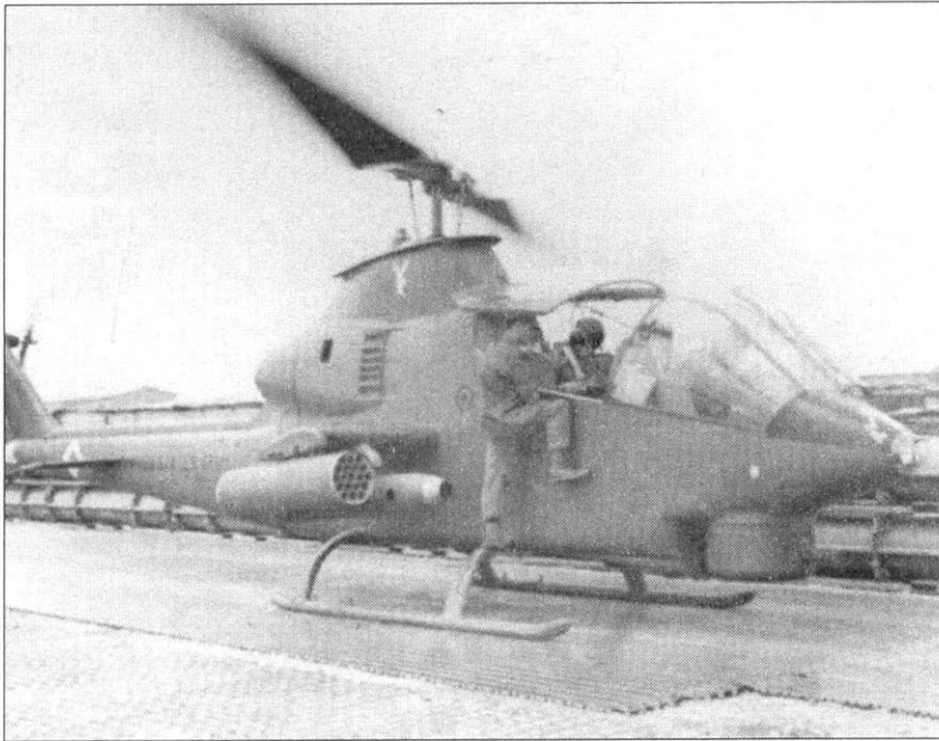
Машина AH-1G «Cobra» ранней производственной серии из 1-го взвода 334 АНС, Бьенхоа, апрель 1968 года. Машина несет типичное вооружение (с башенкой TAT-102). Снаружи на пилонах подвешены пусковые установки XM-159, а ближе к фюзеляжу гондолы с «миниганами» XM-18. В кабине сидит командир взвода, майор Р. Грей. 334 АНС была первой частью, полностью оснащенной «Кобрами».
