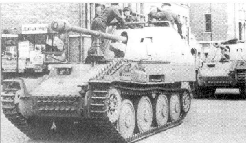
В 1944 г. немцы стянули в Бельгию значительные бронетанковые силы. Истребители танков Sd.Kfz. 138 Ausf. M, несмотря на тонкую броню, принимали участие в боях наравне с танками. Пушки Pak 40/3, которыми были вооружены самоходки, могли успешно поражать почти все танки союзников.
