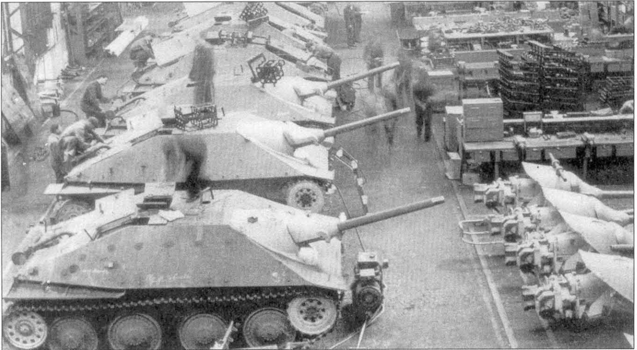
Сборочная линия истребителей танков Jagdpanzer -38, цех завода фирмы ВММ, 19 июня 1944 г.
