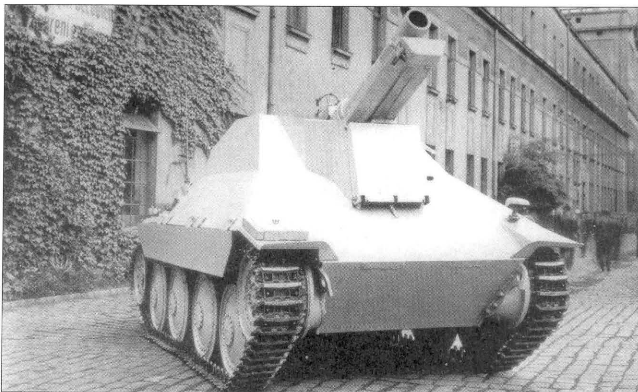
Когда гаубица поднималась на максимальный угол возвышения, вырез в лобовом бронелисте мог закрываться специальным щитком, этот же щиток стабилизировал лафет орудия при движении самоходки.
