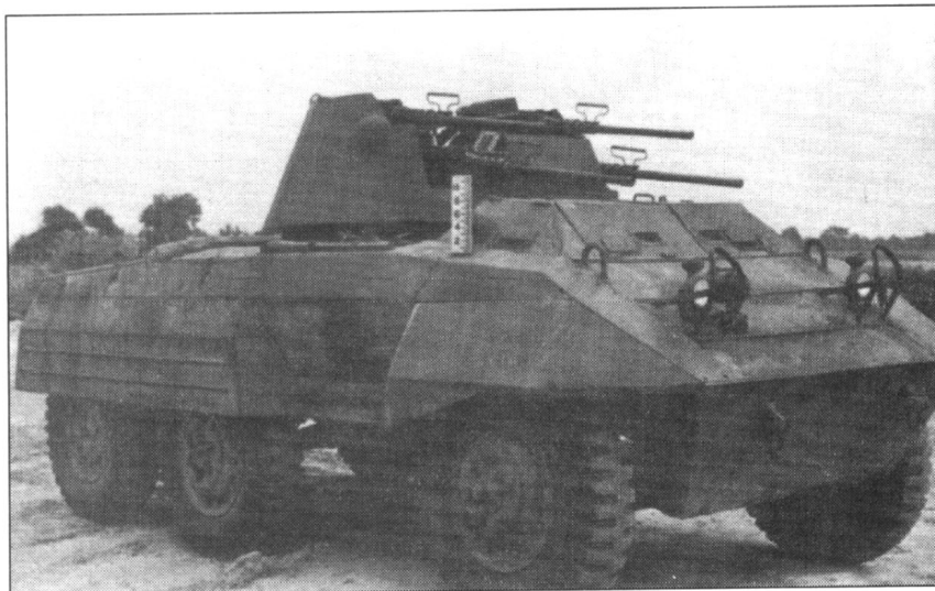
Броневедомитель Т69 представлял собой адаптированную к решению задач ПВО машину М8. В место 37-мм пушки в открытой сверху башне кругового вращения устанавливались четыре 12,7-мм пулемета; боекомплект размещался внутри машины.
