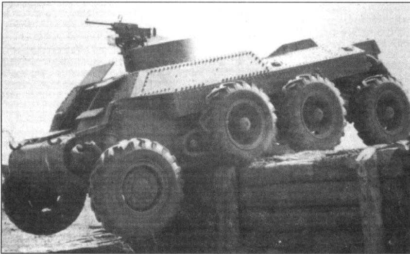
Одним из первых американских броневых автомобилей являлся так называемый «безбашенный танк». Конструкция ходовой части машины отличалась использованием восьми колес на подвеске Кристи. Жесткость конструкции машины оказалась недостаточной и дальнейшие работы по программе пришлось прервать.
