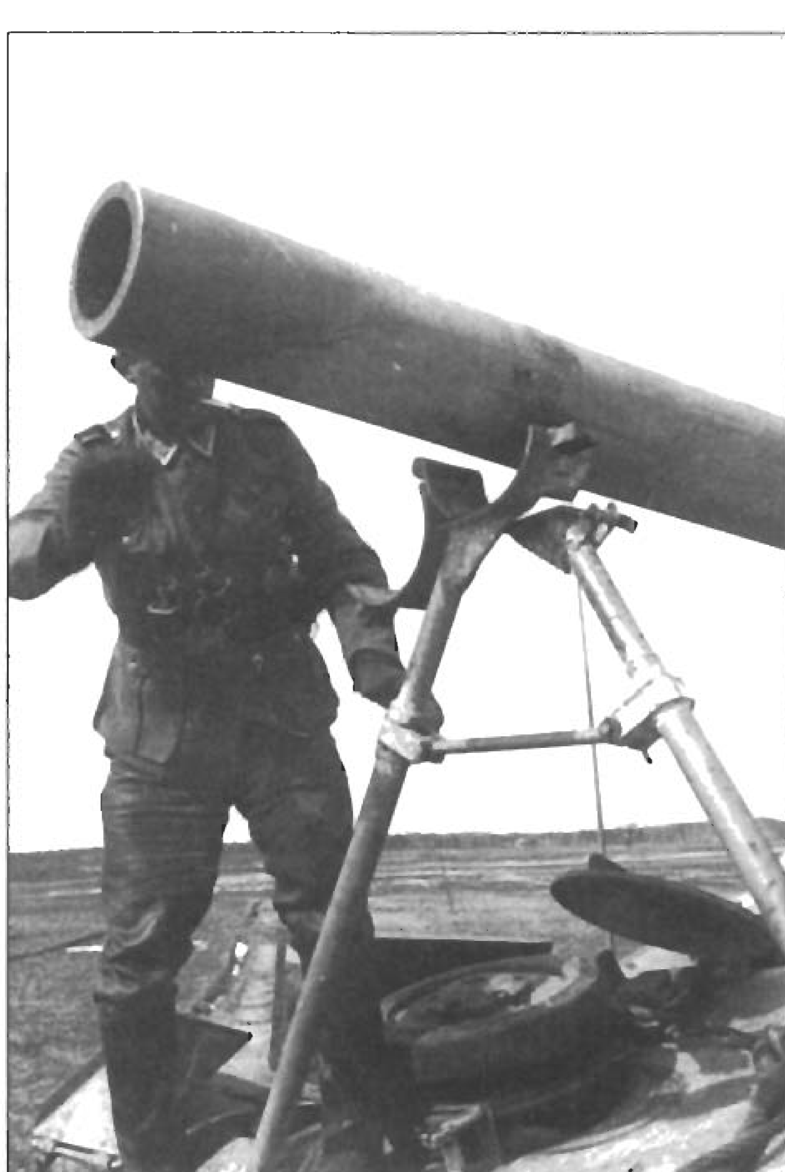
Член экипажа самоходки крепит ствол пушки в походное положение, эта САУ раннего выпуска. Закрепить орудие в походное положение изнутри боевого отделения невозможно.
