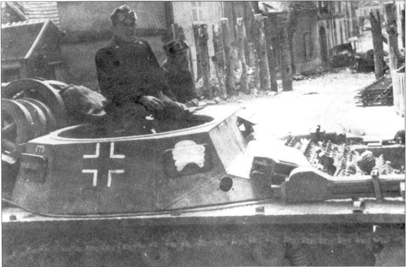
На этой редкой фотографии 1939-1940 годов можно увидеть эмблему 3-й танковой дивизии. Легкий танк PzKpfw I Ausf A, который мы здесь видим, переделан в ремонтно-эвакуационную машину. «Мертвая голова» (Totenkopf) - это эмблема танковых войск. Дивизионный значок желтого цвета - весьма стилизованное изображение Бранденбургских ворот в Берлине, городе, в котором формировалась эта дивизия.
