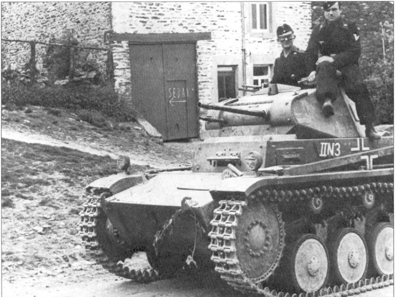
Легкий танк PzKpfw II Ausf C из 2-й танковой дивизии на пути к Седану. Номер на борту свидетельствует о принадлежности к взводу связи при штабе второго батальона. В 1939-1940 годах эмблемой дивизии служили две небольшие желтые точки, расположенные перед крестом - знаком национальной принадлежности. Обозначения на этой машине выполнены белым цветом. Обратите внимание на оригинальным образом нарисованный крест - разбитый на две части.
