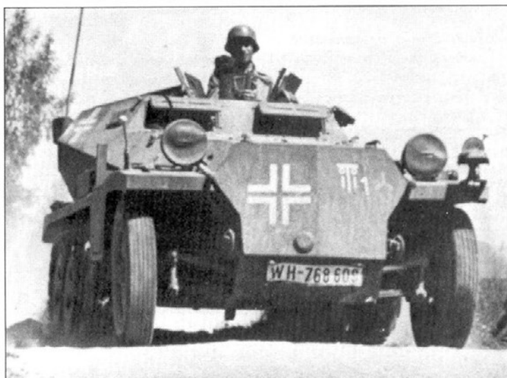
Сфотографированный в России полугусеничный бронетранспортер SdKfz 253 артиллерийских наблюдателей из 1-й танковой дивизии несет желтую дивизионную эмблему и белый тактический значок первой батареи батальона буксируемых орудий.
