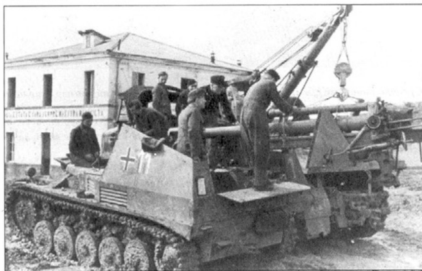
Самоходное орудие Wespe сфотографировано в Италии в 1943 году, имеет двухзначный номер, говорящий о том, что это первое орудие первой батареи. Номер, написанный мелом на борту надстройки - 31051. Это номер шасси. Как видно на снимке, орудие у этой самоходной установки заменялось довольно легко.
