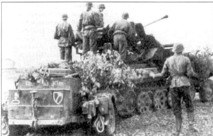
Зенитная самоходная установка - 37 мм пушка Flak 36, установленная на полугусеничном тягаче SdKfz 6 сфотографирована в России в ходе операции «Барбаросса». Судя по белым тактическим знакам, эта установка из 2-й самоходной зенитной батареи. Дивизионная эмблема - стандартного образца используемого «ЛАН» во время вторжения в Россию. Обратите внимание на белую надпись на заднем борту прицепа, предписывающую сохранять положенную дистанцию при следовании в колонне.
