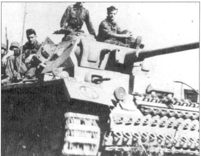
Средний танк PzKpfw III Ausf J, сфотографированный в 1943 году, окрашен в темно-желтый цвет. Эмблема дивизии «Викинг» нарисована белой краской на фоне круга черного цвета. Башенный тактический номер красный с белой обводкой, покрыт толстым слоем пыли.
