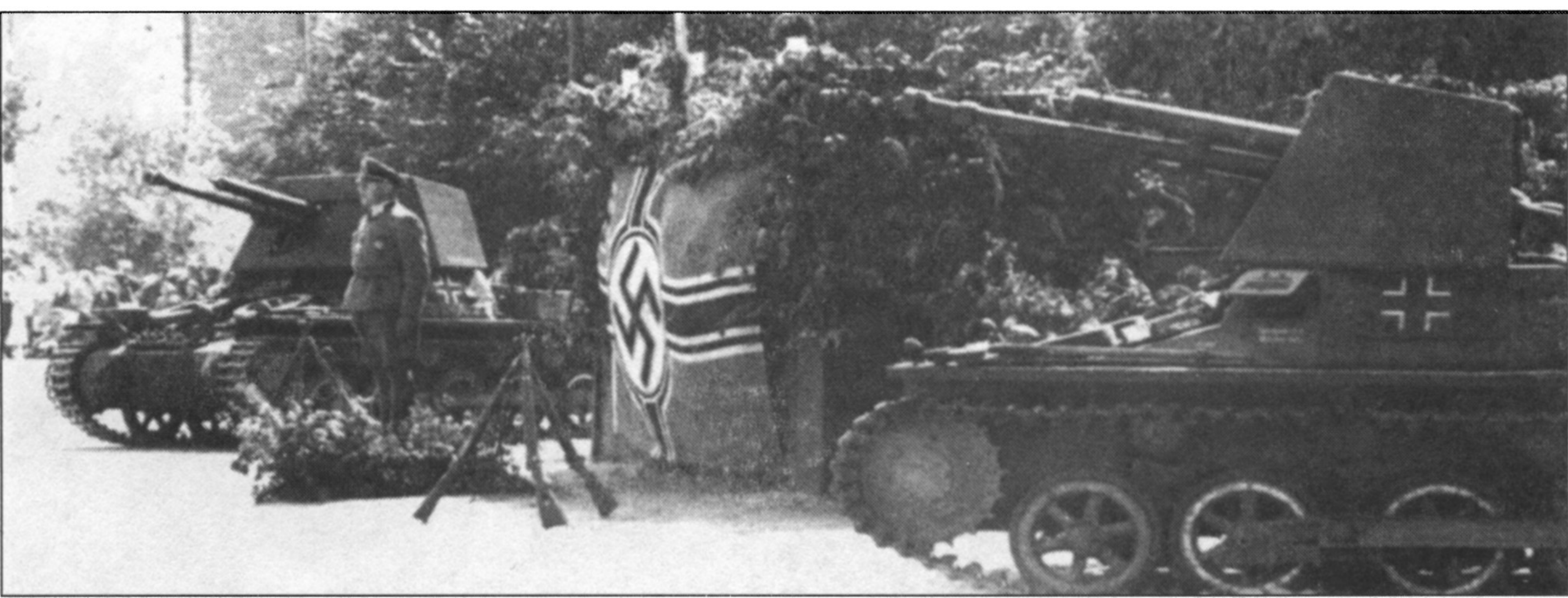
Два Panzerjäger I во время принесения клятвы в одной из частей вермахта. Обратите внимание на широкий балочный крест. Запасные траки и опорные катки уложены на лобовой броне. У обеих машин сняты передние крылья.
