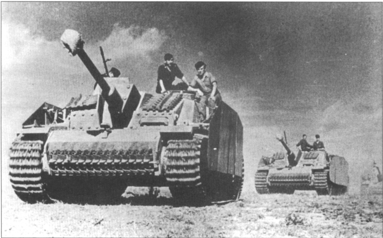
Штурмовые орудия, оборудованные траками Ostketten, лето 1944 г. Экраны штурмовых орудий снабжались скобами с двумя пазами, в которые входили треугольники несущих ферм. Если на машину ставились узкие гусеницы, то треугольники ферм вставлялись в ближний к экрану паз, если гусеницы были широкими - то в дальний. Поэтому при смене гусениц не надо было менять экраны.
