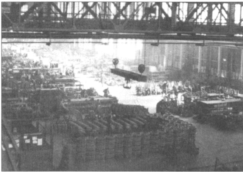
Цех фирмы Алкетт. Видны штабеля опорных катков для штурмовых орудий.
