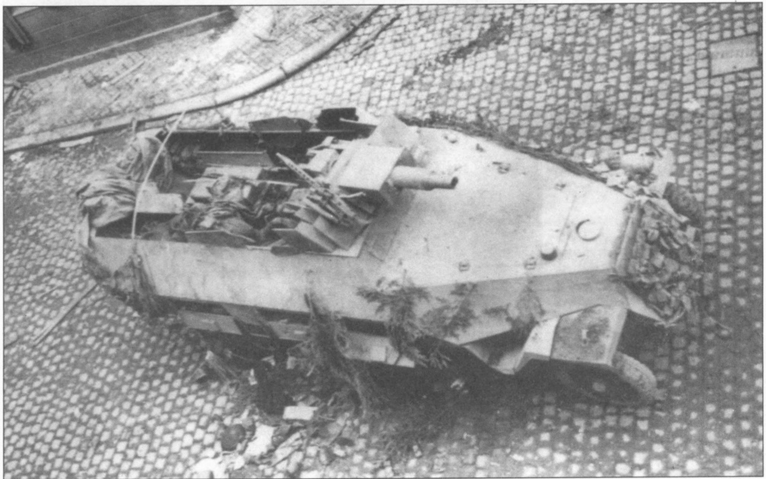
Вид сверху на брошенный SdKfz 251/9 Ausf. D поздней серии, Нормандия, июль 1944 года. Видны радиостанция с головными телефонами, унитарные выстрелы. Боевое отделение машины набито различным снаряжением.
