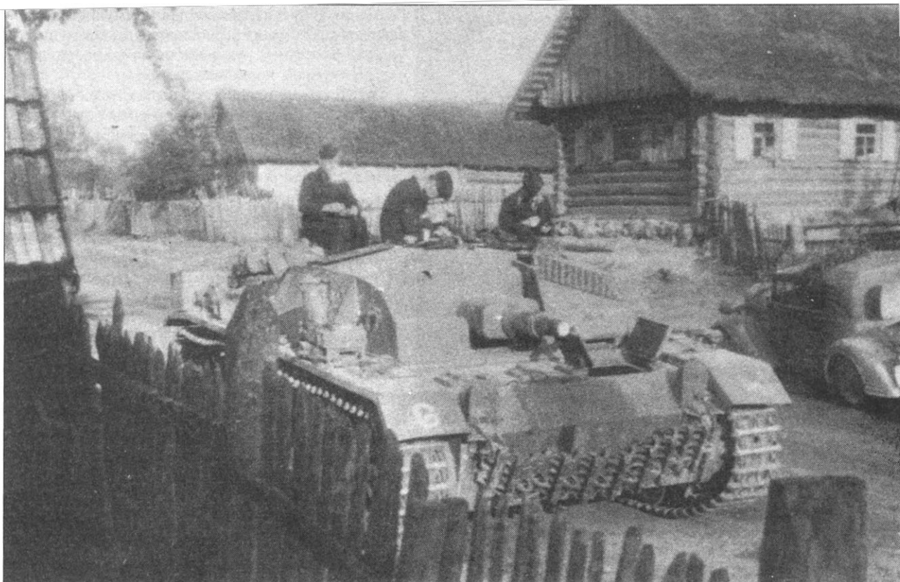
Ранний вариант штурмового орудия StuG III отличался короткоствольным 75-мм орудием. Короткоствольная 75-мм пушка оказалась неэффективной против большинства типовых целей, поэтому ее заменили длинноствольной.
