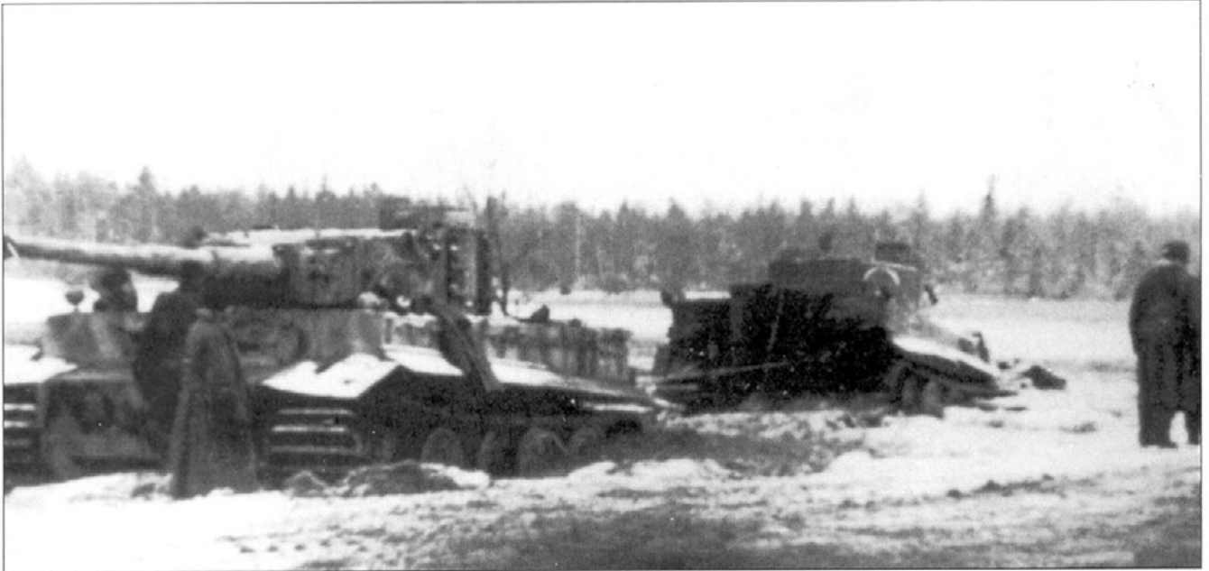
Снимок сделан осенью 1943 г. в районе Невеля. Танк «Тигр» с бортовым номером «224» вытаскивает завязший в грязи другой «Тигр».
