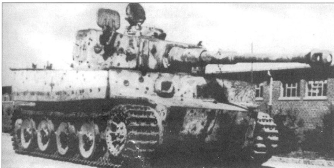
«Тигр» с бортовым номером «121». Обратите внимание на выщерблины в броне, в этот танк попало не менее 250 снарядов и осколков. Точно так же выглядел и «Тигр» с бортовым номером «141», сражавшийся бок о бок со «121-м».
