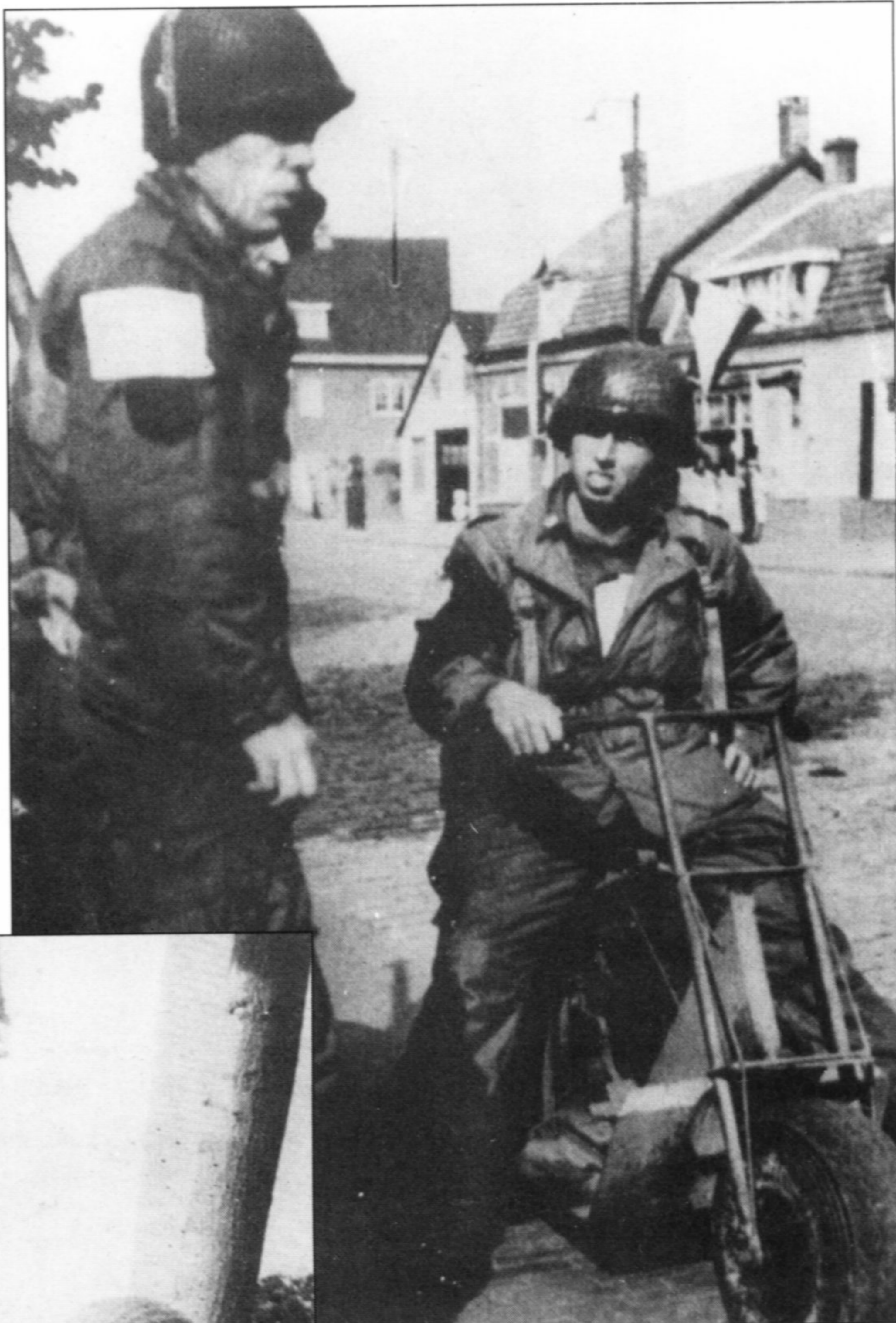
Мотороллер Cushman оснащался одноцилиндровым четырехтактным 244-кубовым двигателем. Машина имела грубую и примитивную конструкцию, но обеспечивала парашютистам высокую мобильность после приземления.
