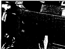
16.2A Снятие выключателя, установленного на панели приборов
