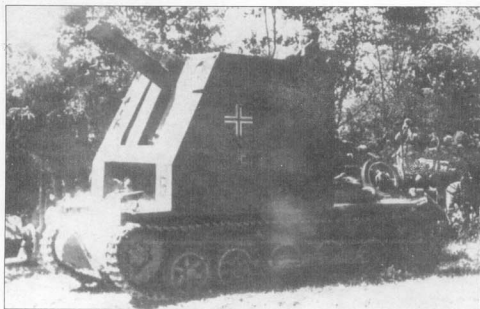
Установленная на шасси танка Pz.Krfw. I 150-мм тяжелая полевая гаубица получила обозначение sIG 33(Sf). Снимок сделан в момент обстрела самоходной позицией греческих войск. По эмблеме на лобовом бронелисте рубки можно установить принадлежность самоходной гаубицы - 704-я рота 5-й танковой дивизии. Ниже креста на стенке рубки изображена литера «E», обозначающая четвертую машину в подразделении. В феврале 1940 г. в такие самоходно-артиллерийские установки было конвертировано 38 танков Pz.Krfw. I.
