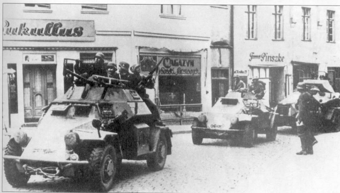
В авангарде танковой дивизии обычно шли броневомобили. Снимок сделан на улице польского городка. Первые две бронемшины - Sd.Kfz. 222, самые популярные немецкие броневомобили периода Второй мировой войны. Третья машина в колонне - трехосный тяжелый броневомобиль Sd.Kfz. 231 выпуска 1932 г. К 1939 г. машины Sd.Kfz. 231 считались устаревшими, хотя и использовались до самого конца войны. На передних бронелистах капотов моторов головных броневомобилей нанесены опознавательные знаки в виде белых крестов. Обратите внимание на отражение в стекле витрины магазина белого креста, нанесенного на правый борт второй бронемшины.
