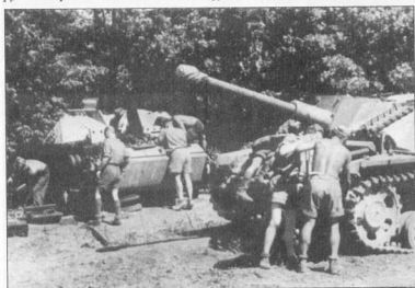
Ремонт штурмовых орудий. Снимок сделан в Западной Европе незадолго до высадки союзников в Нормандии. На самоходке, которая на снимке слева, демонтированы ведущие колеса, приводные валы и орудие. На правой машине чинят тормоза.
