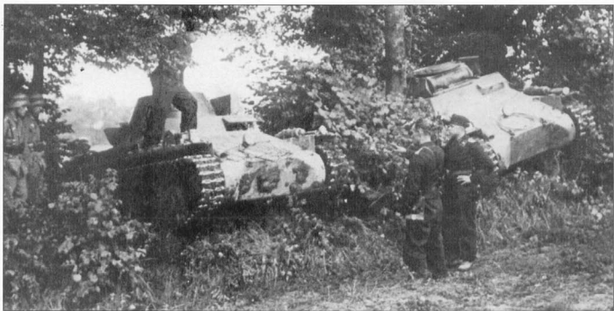
Пара танков Pz.Krfw. I Ausf. A сфотографирована среди деревьев на обочине шоссе, учения 1936 г. Pz.Krfw. I Ausf. A впервые были показаны публично на учениях в 1934 г., в год принятия на вооружения. Танк не отличался удачными конструктивными решениями, но он стал первым танком панцерваффе. Тем не менее, учебная в общем-то машина принимала широкое участие в боевых действиях.
