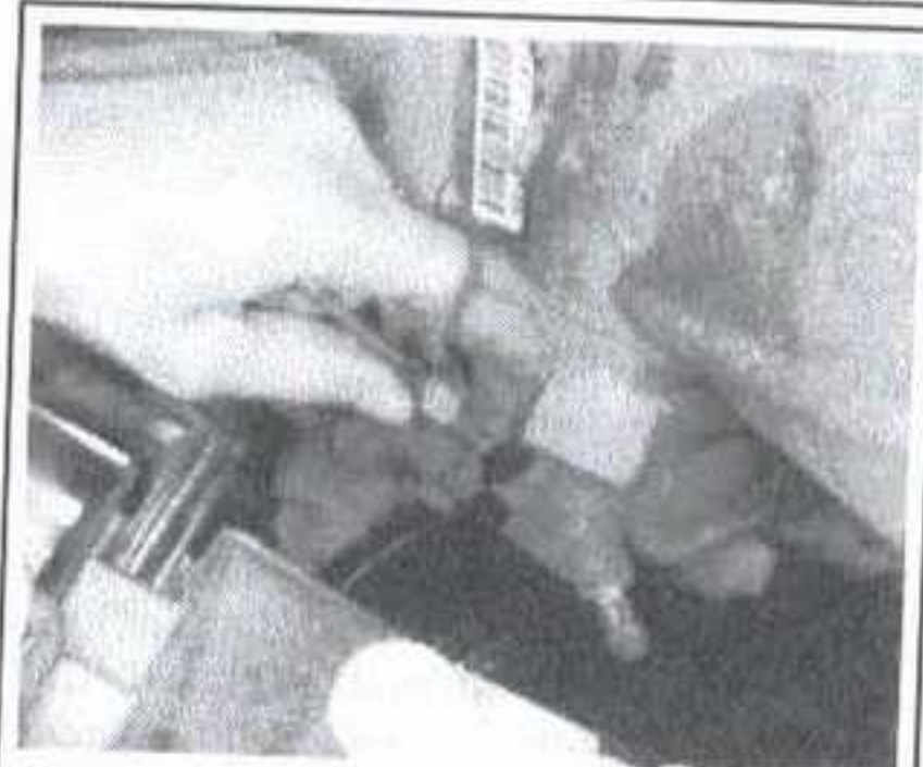
Рис. 57 Отсоединение гидравлической линии от рабочего цилиндра
