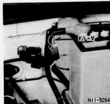
ヒューズブル リンク(バッテリー右側)
