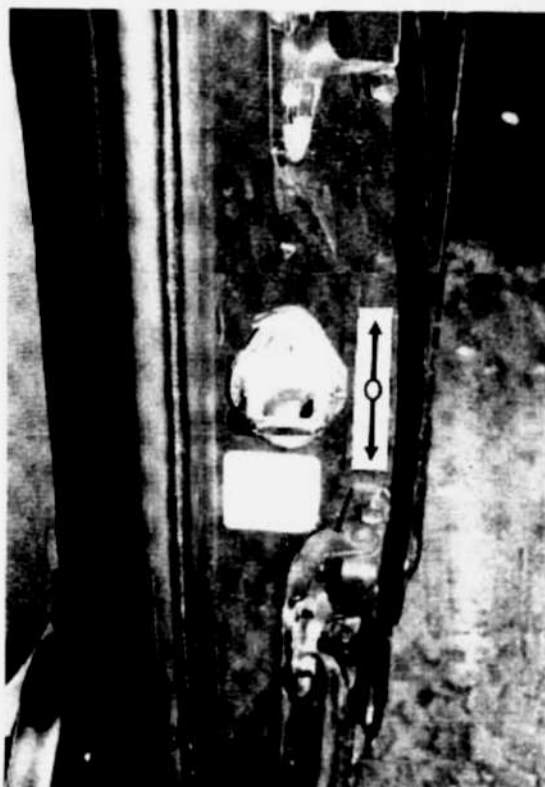
Rys. 7.15. REGULACJA POŁOŻENIA ZACZEPU ZAMKA
